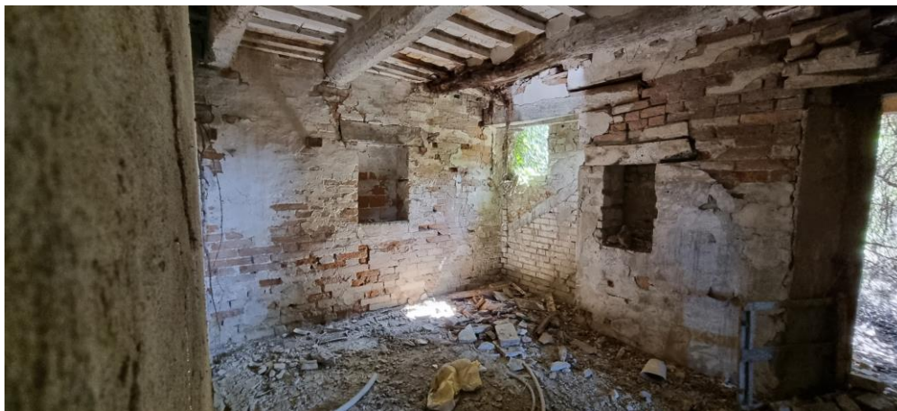
11 – Fabbricato piano terra rimessa deposito
