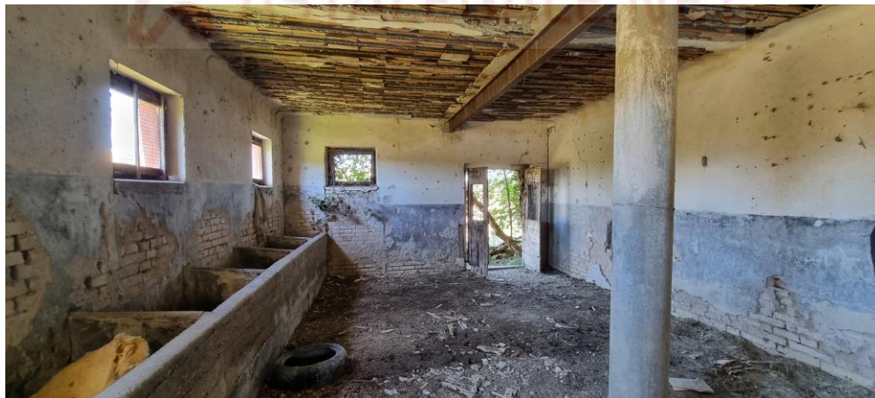
9 – Fabbricato piano terra stalla
