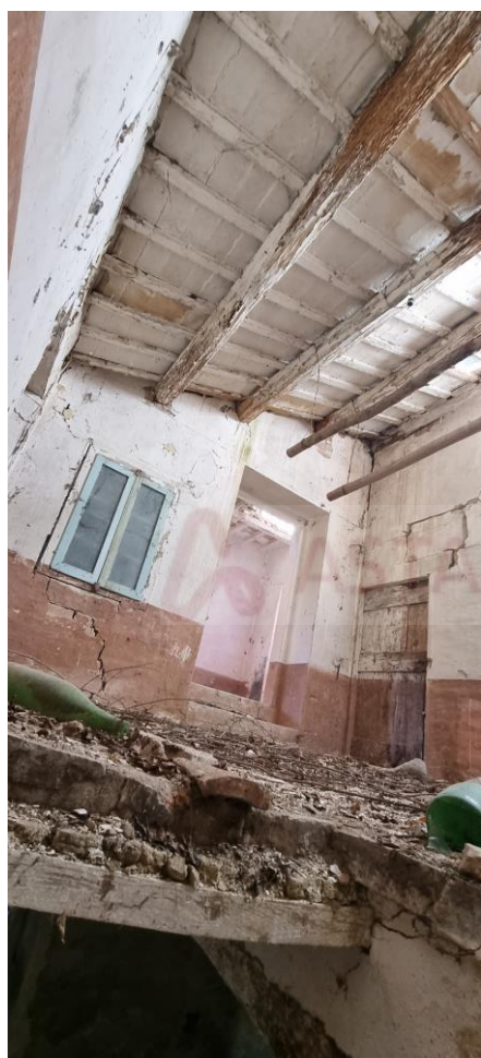
12 – vista del piano primo
