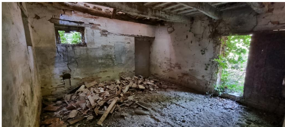
10 – Fabbricato piano terra rimessa deposito
