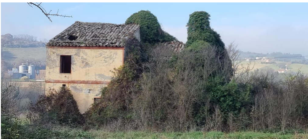
4 – Fabbricato lato sud est
