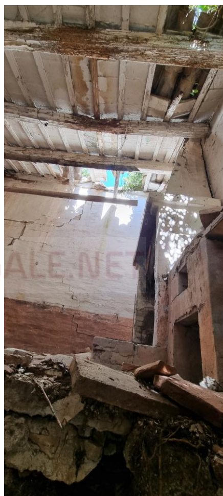
13 – vista del piano primo
