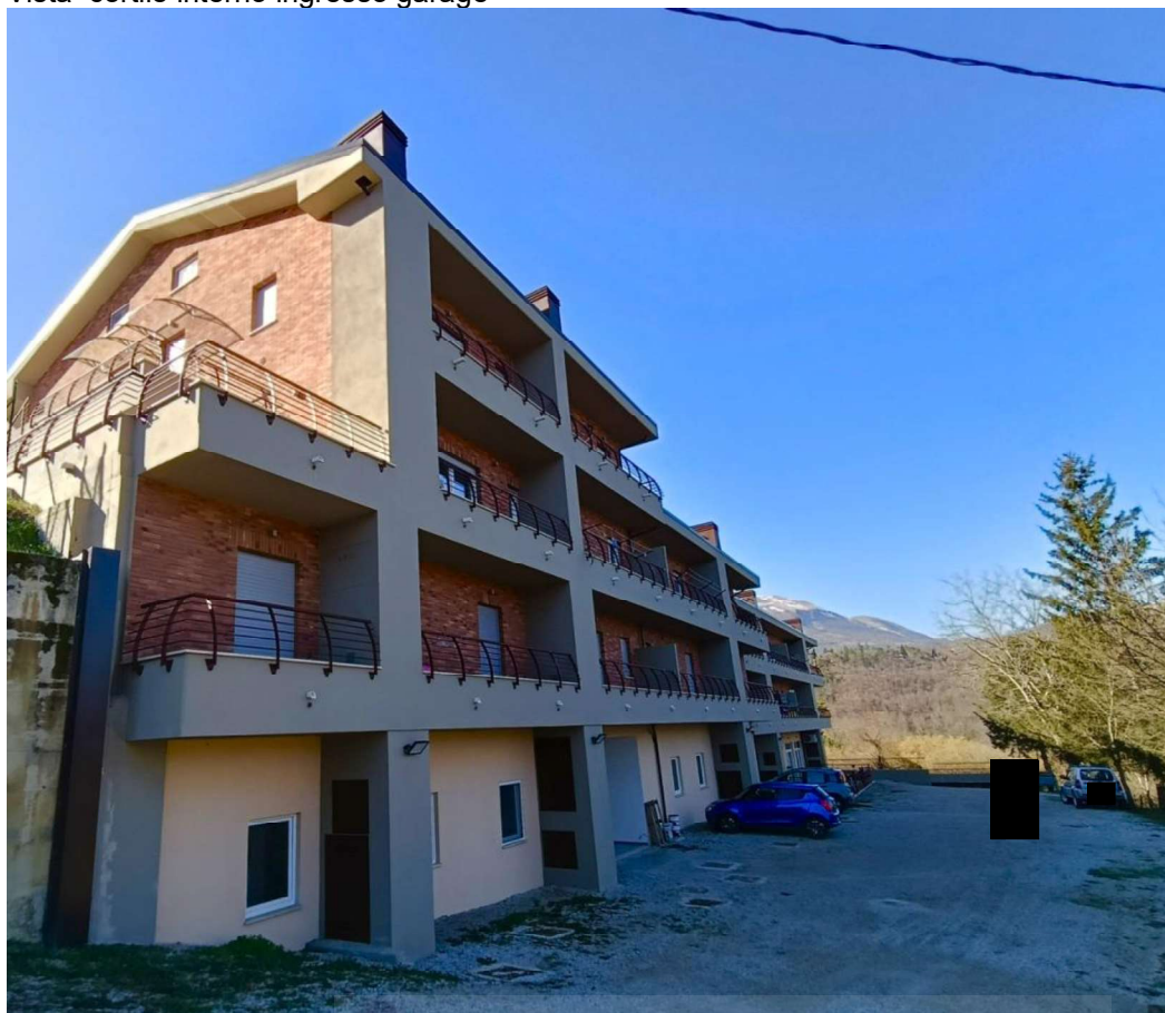
Vista cortile interno ingresso garage
