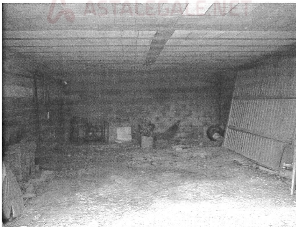
EDIFICIO ACCESSORIO (interni piano 1° sottostrada)
