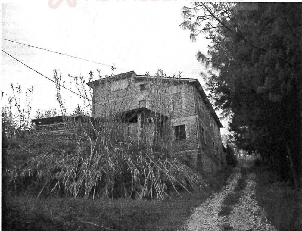
EDIFICIO PRINCIPALE (vista sud – est)
