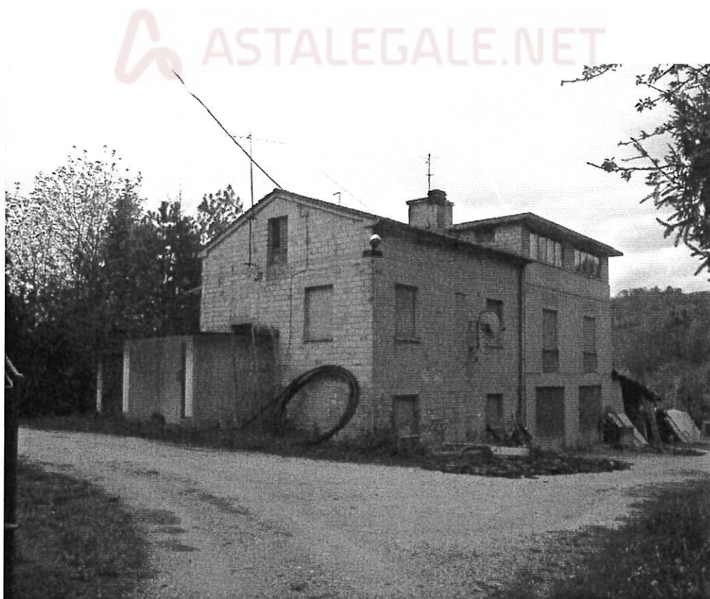
EDIFICIO PRINCIPALE (vista nord – ovest)
