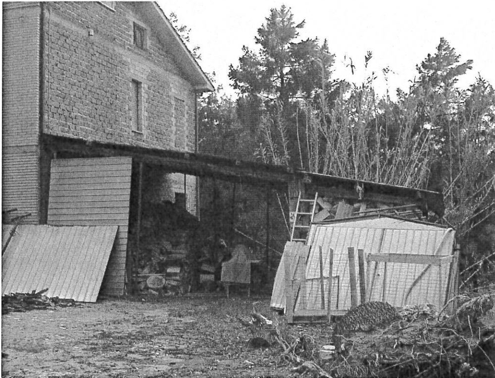
EDIFICIO PRINCIPALE (tettoia abusiva da demolire)
