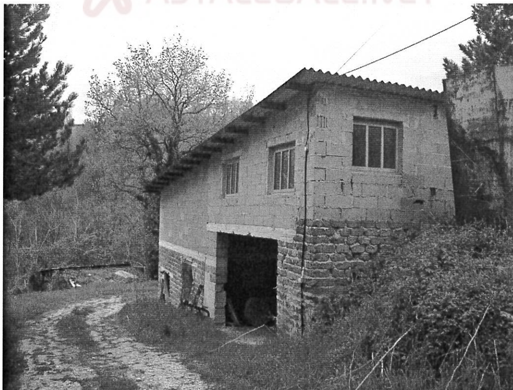
EDIFICIO ACCESSORIO (vista nord - est)
