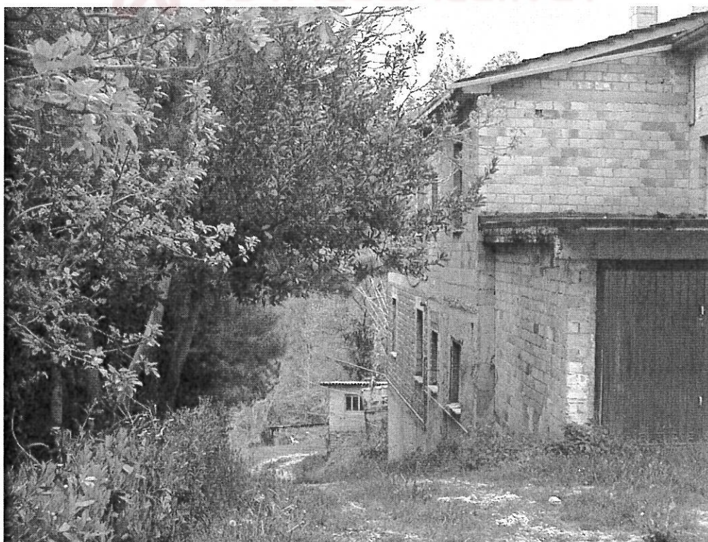
EDIFICIO PRINCIPALE (vista est)
