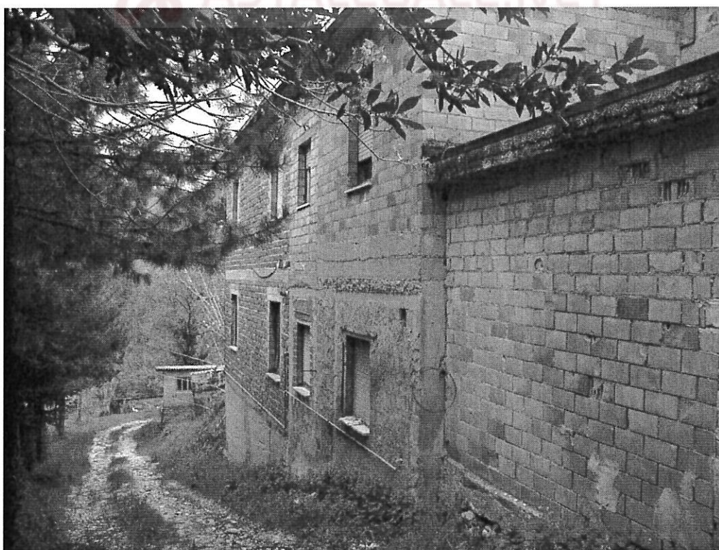
EDIFICIO PRINCIPALE (vista est)
