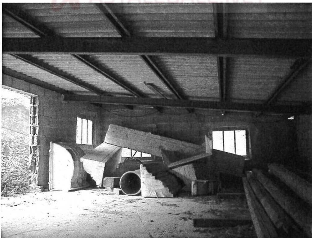
EDIFICIO ACCESSORIO (interni piano terra)
