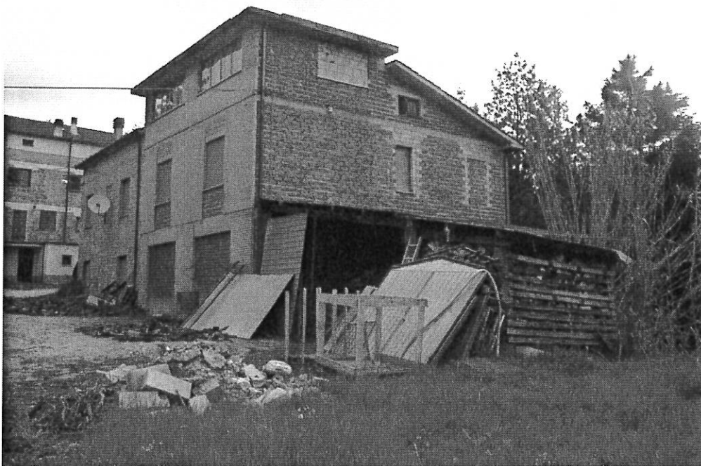
EDIFICIO PRINCIPALE (vista sud – ovest)
