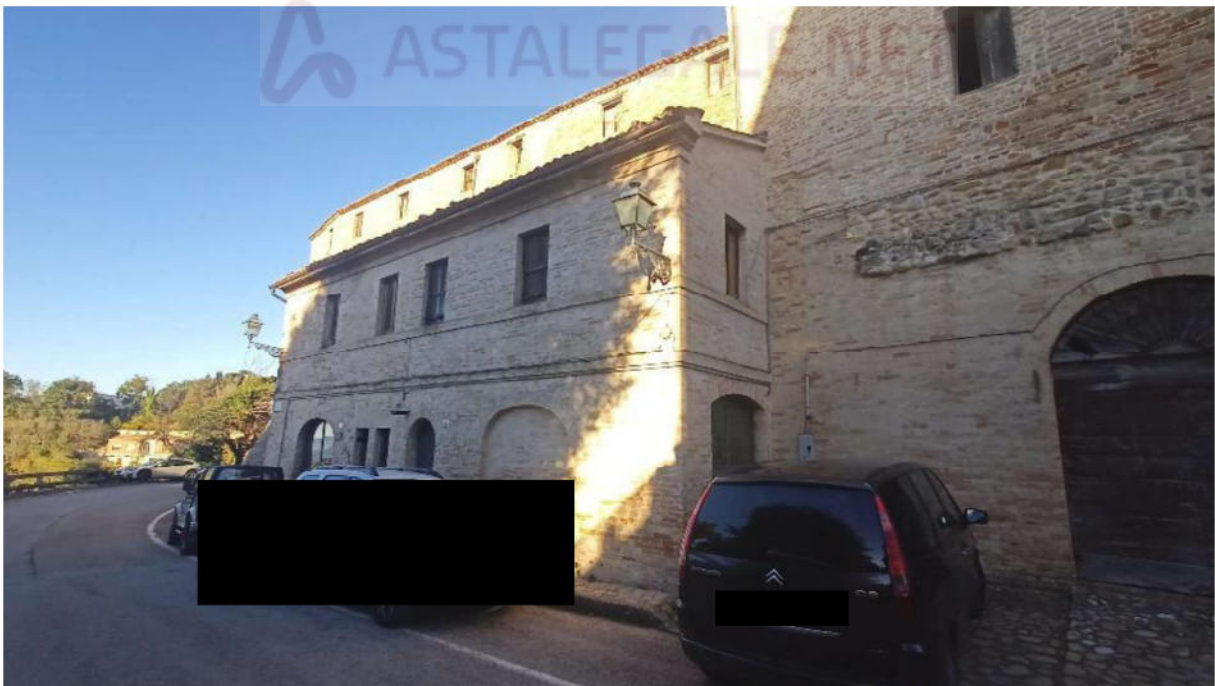
2. Ingresso fronte SUD sub.3
